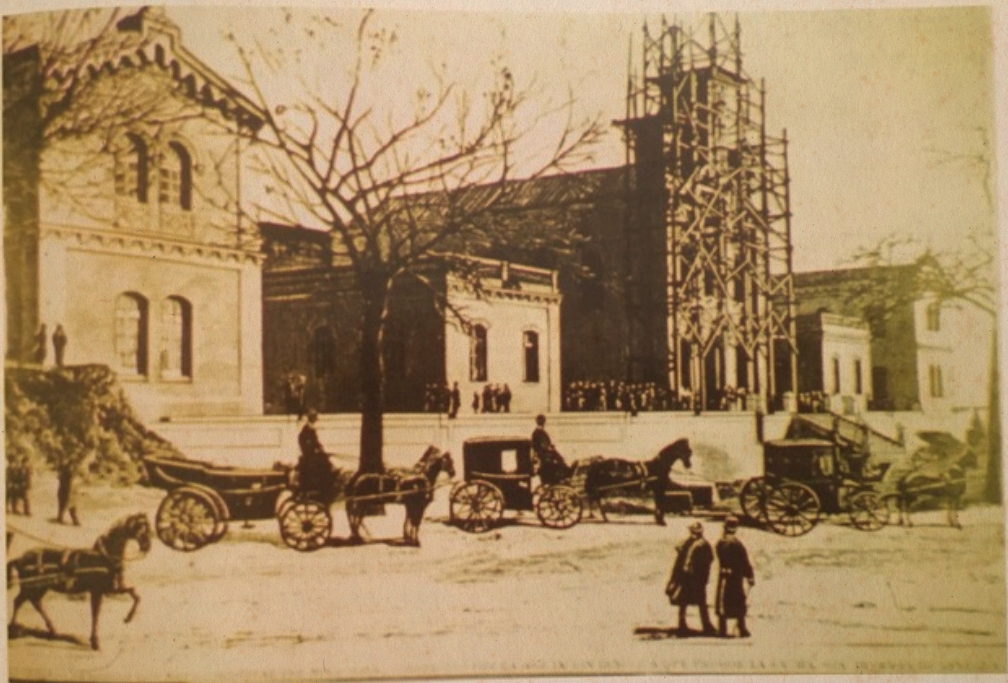
Figura 2: Obras en la fachada principal. (La Ilustración Hispano-Americana)
